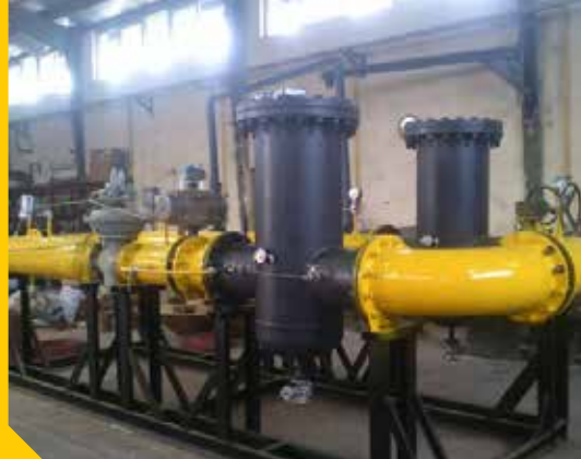
▲ طراحی، ساخت و مونتاژ ایستگاه گاز سیمان آبیک (آبان ۱۳۹۳)
